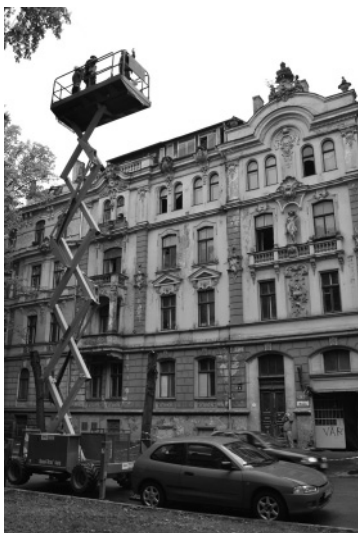
Рис. 1. Вид на фасад здания.
