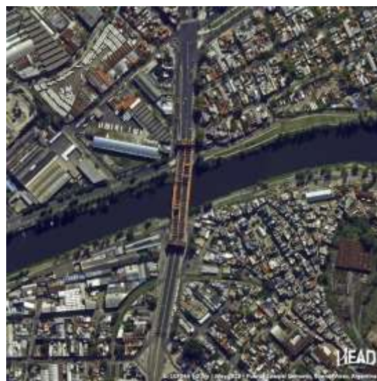
2022 Пуэнте Эсекьель Демонти, Буэнос-Айрес, Аргентина JL-1GF04A, 0.3 м, май 2022
